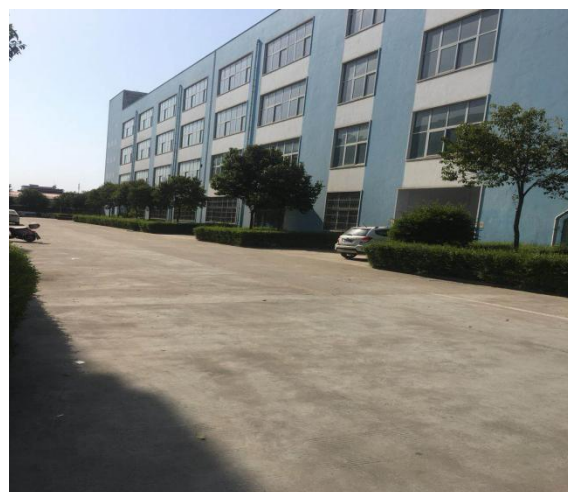
项目北侧—厂房
