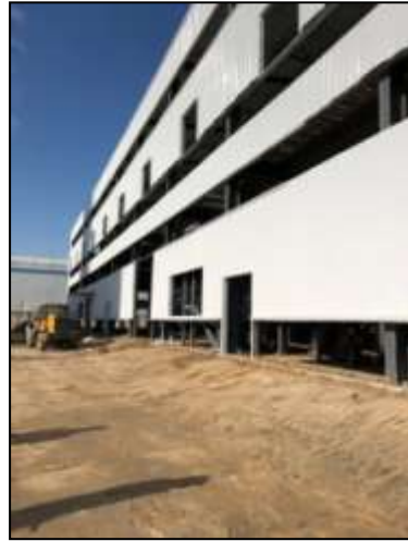
北厂区车间现状
