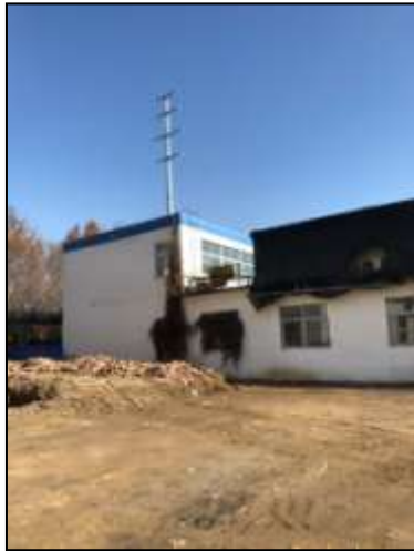
北厂区东侧能信维修设备房
