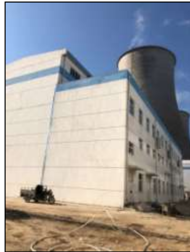
北厂区南侧能信备压机房
