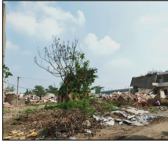
项目北侧拆除闫庄村
