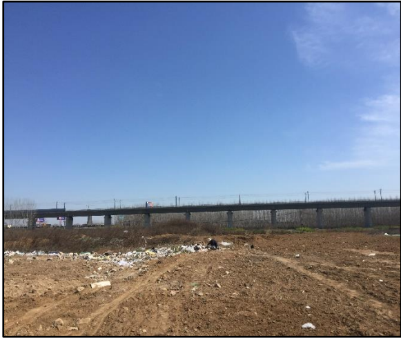
项目东侧石武高铁
