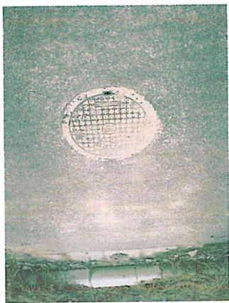
项目南侧金龙街污水管网
