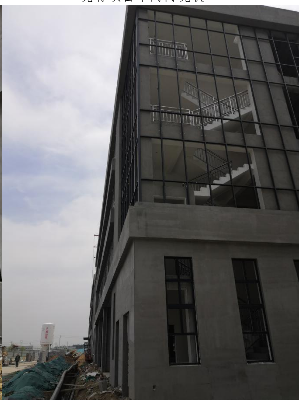
拟建项目厂房现状
