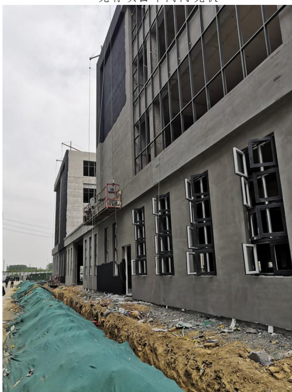
拟建项目厂房现状
