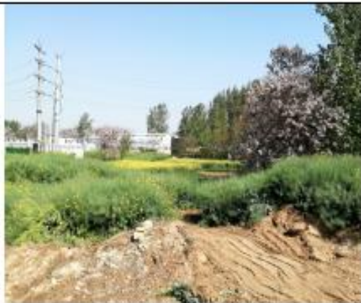
项目起点现状
