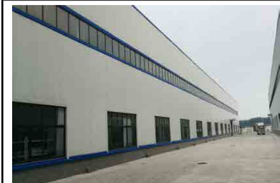
本次改扩建项目所在车间
