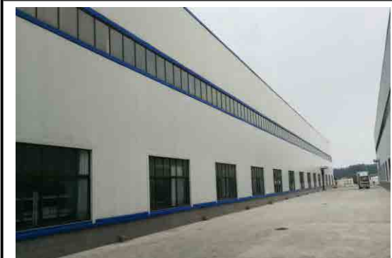
本次改扩建项目所在车间
