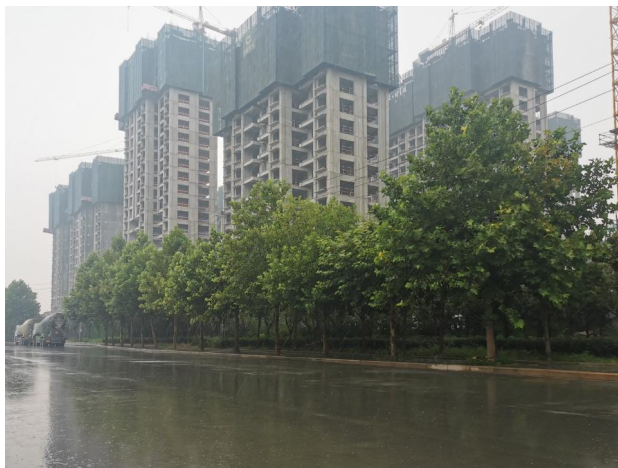
项目北侧--清廉寨安置小区（在建）
