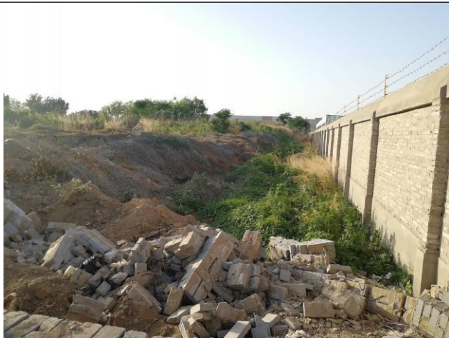
项目厂区现状
