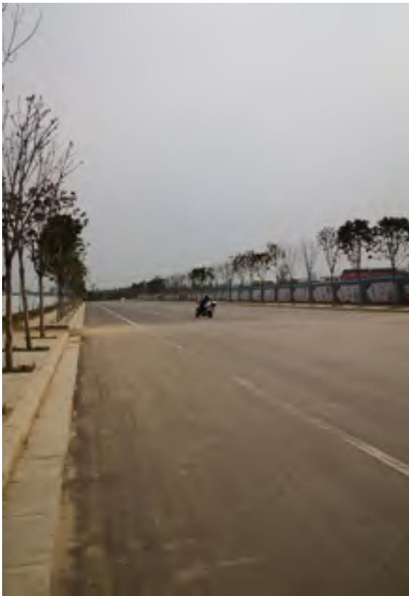
项目厂区西侧
