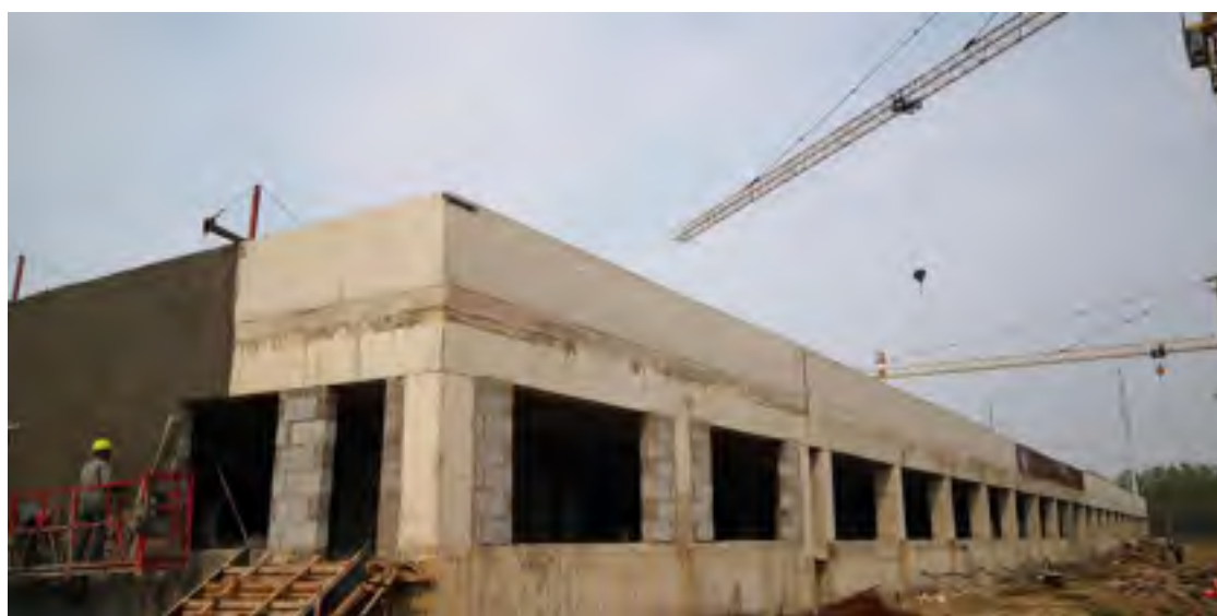
许昌生物医药产业园污水处理厂建设现状
