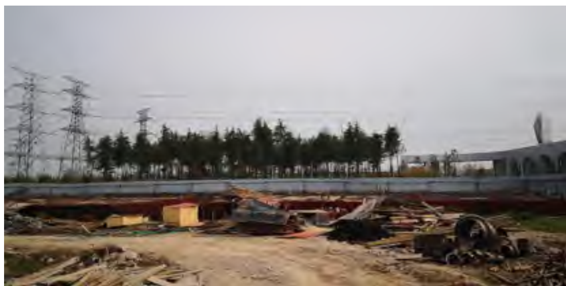
许昌生物医药产业园自来水厂建设现状
