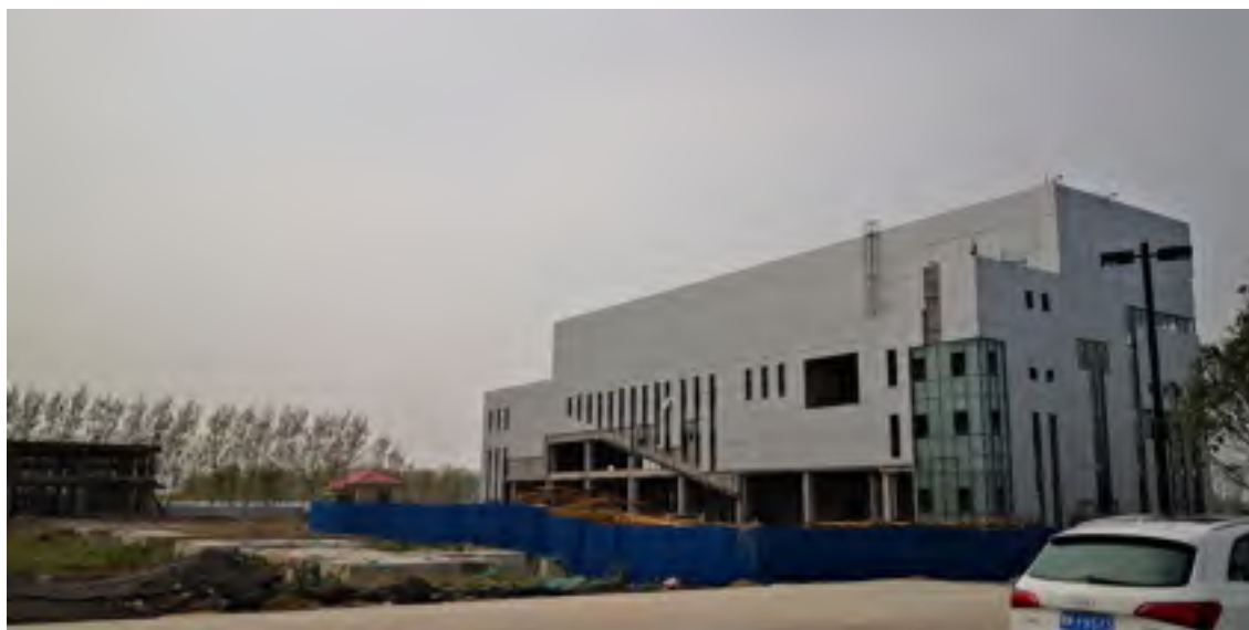
许昌生物医药产业园热电厂建设现状
