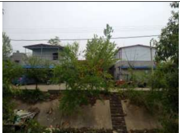
项目东侧白沙南干渠及火山赵村
