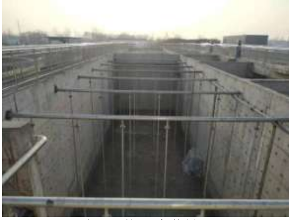
项目现状（生化池）
