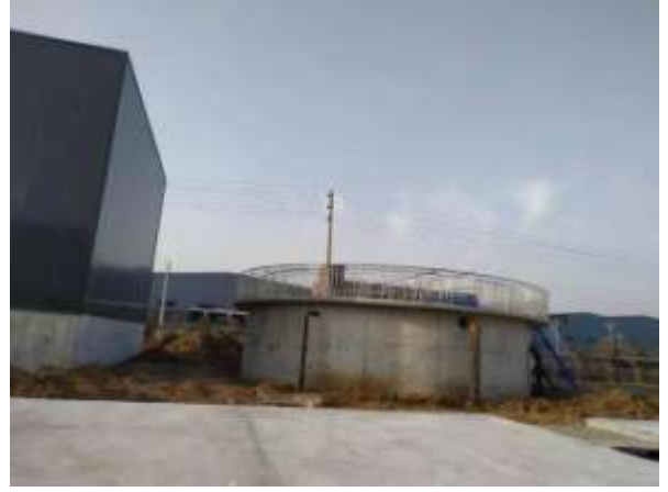
项目现状（污泥浓缩池及脱水车间）
