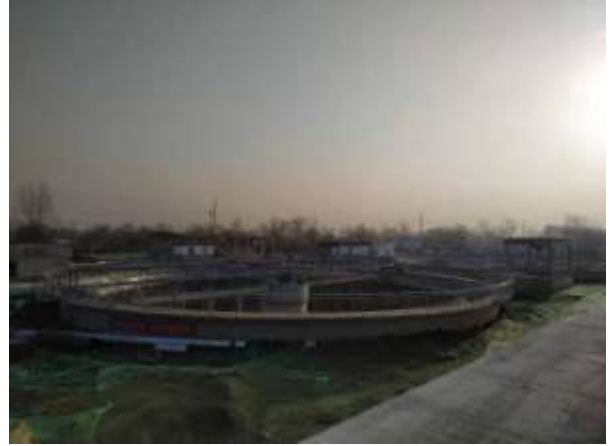
项目现状（二沉池）
