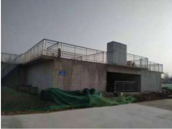
项目现状（混合反应沉淀池）
