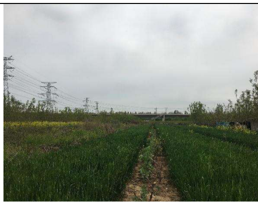
尚北 110kV 变电站拟建站址南侧
