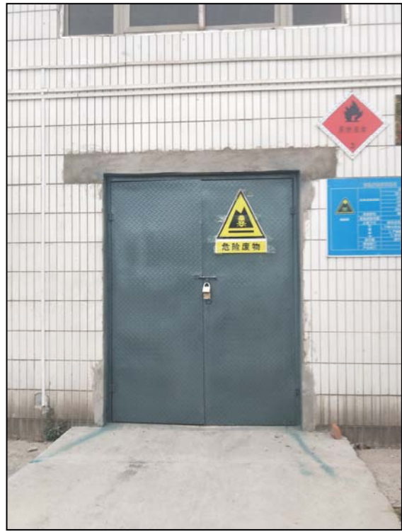
危险废物暂存间
