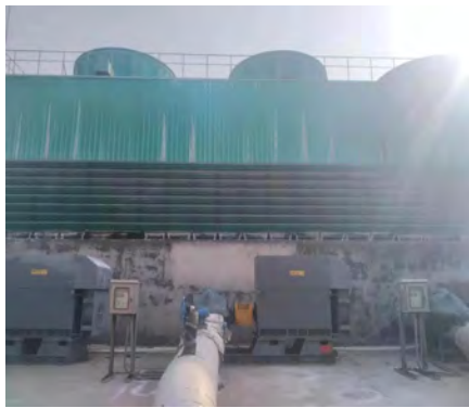
现有的循环水站
