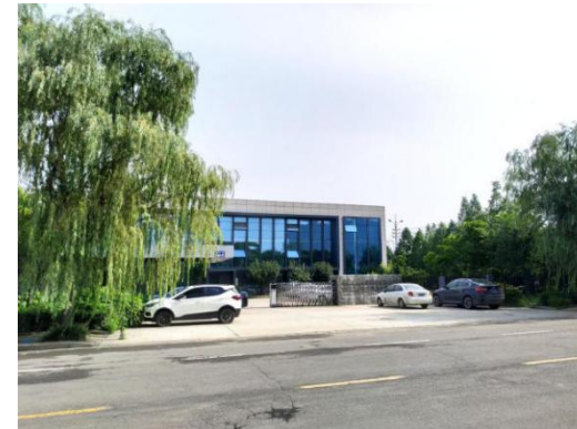
厂区北侧的雷鸣电子公司
