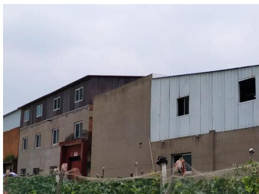
项目北侧的汪庄村
