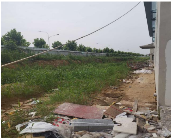
厂区西侧现状
