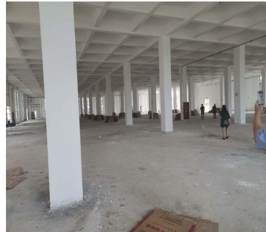
拟建项目厂区二层现状
