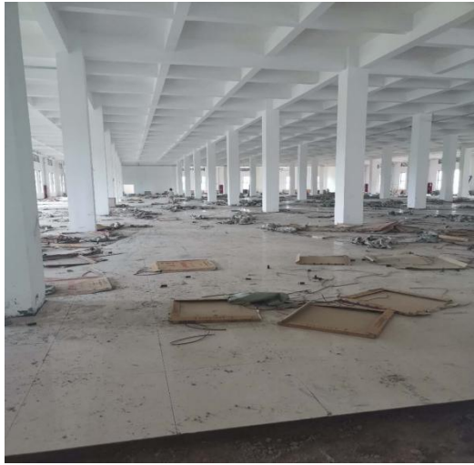
拟建项目厂区二层现状
