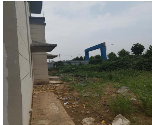
厂区北侧现状
