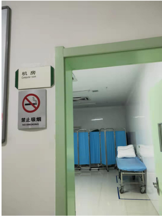
改建场所现状（空机房）
