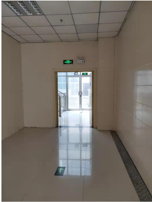
改建场所西侧（楼梯间）
