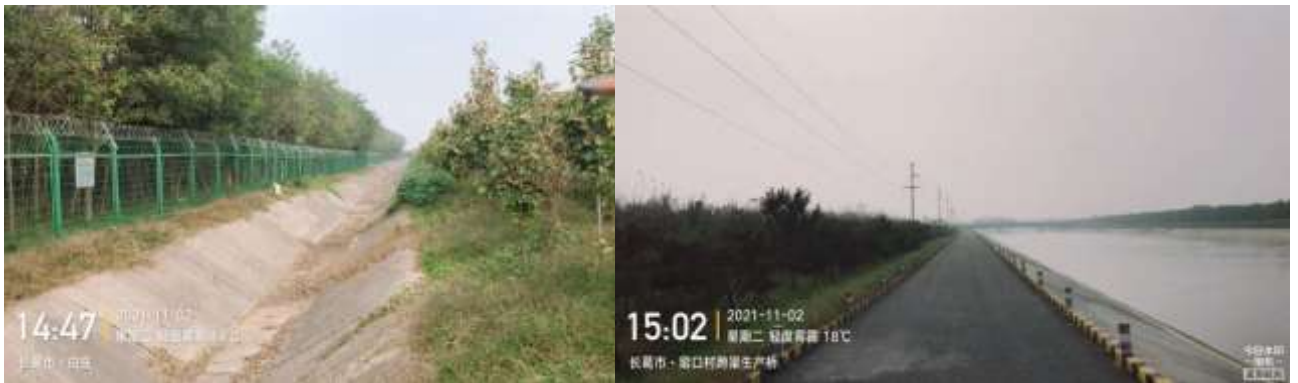
桥位处南水北调总干渠左岸截水沟照片
