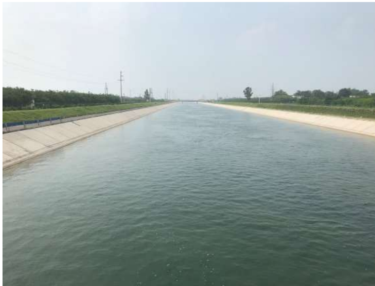
图 2.6-2 南水北调总干渠跨越位置
