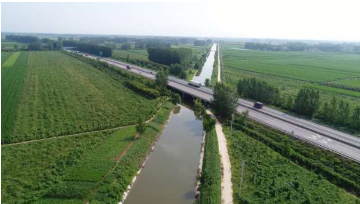
图 3.2-2 拟建匝道桥穿越鹤鸣湖国家湿地公园位置调查照片
