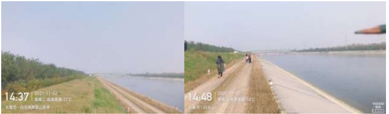
桥位处南水北调总干渠左岸防洪堤照片
