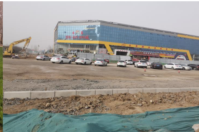
项目厂区北侧现状
