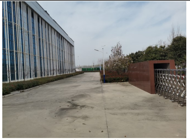
项目厂区现状
