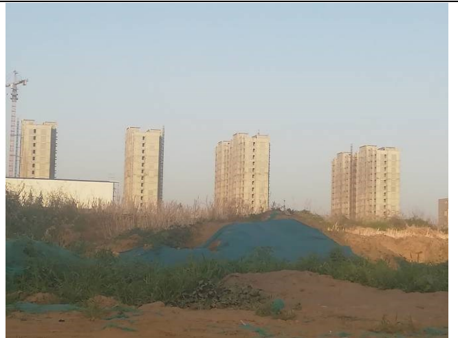
项目东侧 320m 在建朝阳新村
