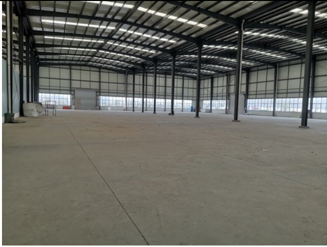
项目厂区现状
