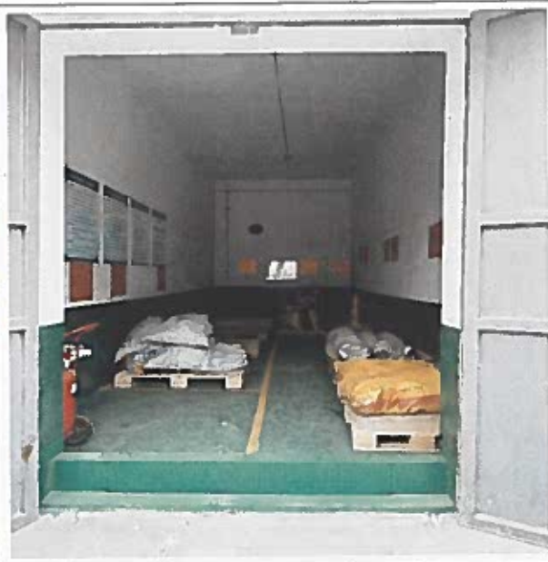
危废间内部防渗及分区
