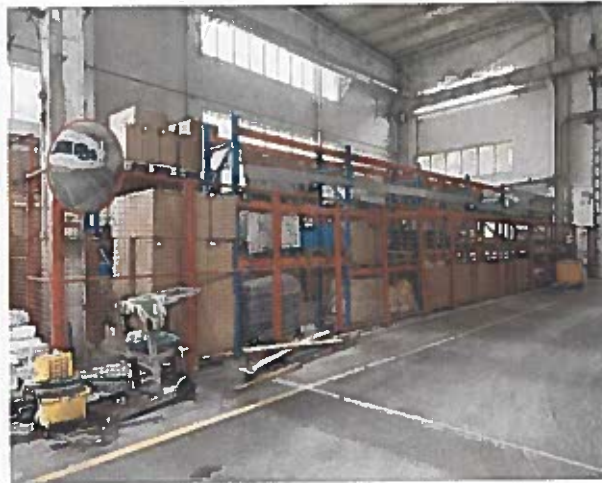
2#厂房内拟建阳极氧化线现状
