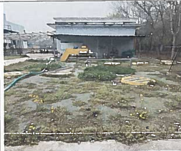
现有废水处理站（CASS+絮凝沉淀+深度过滤）
