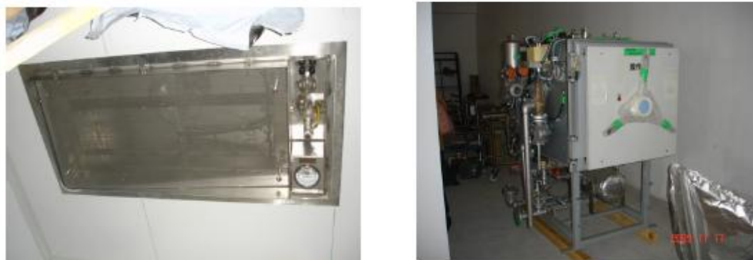
可原位检漏、原位消毒高效过滤器
