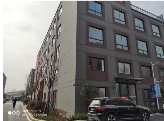
项目南侧—13#A 栋楼
