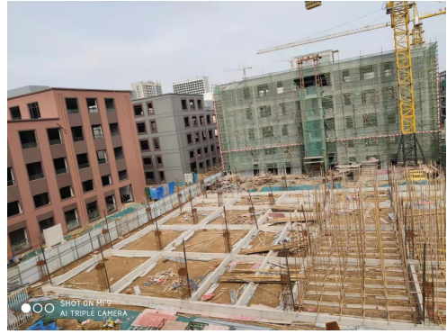
项目北侧—在建 12#楼
