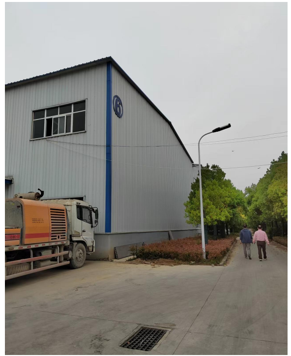
项目 6#、8#厂房之间部分
