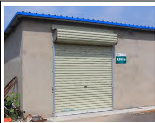
现有危废暂存间
