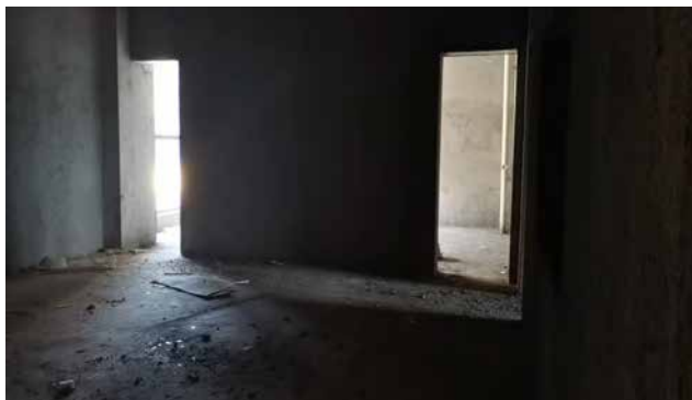
项目机房现状
