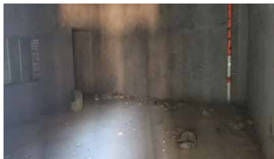
项目东侧操作间现状
