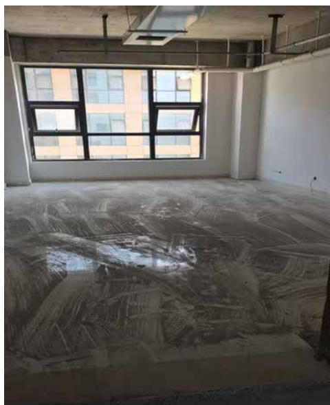
项目正对四楼病房
