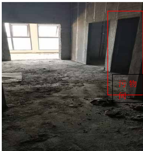
项目东侧污物通道
