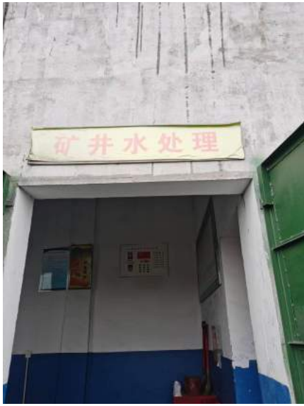
矿井水处理系统
