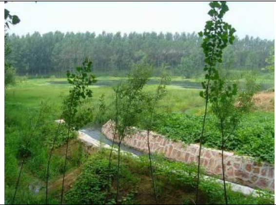
工业场地排水入颖河口（排放口）
