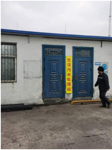
生活污水处理站
