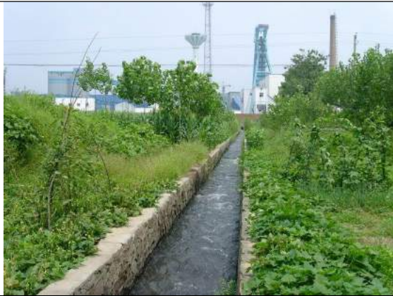
煤矿工业场地排水口（总排口）
