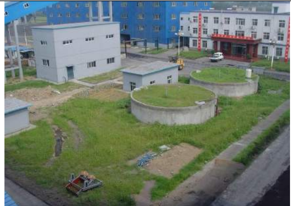
消防水池旁绿化
