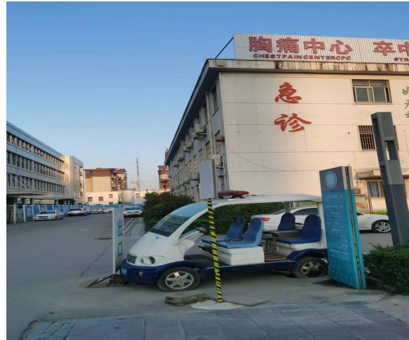
急救中心综合楼南侧门诊楼-急诊
