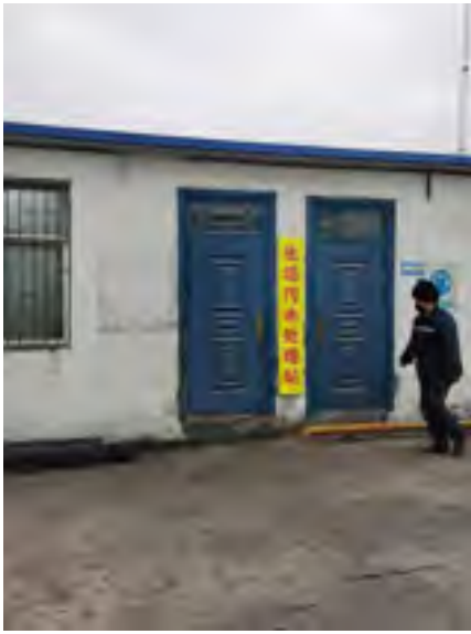
生活污水处理站
