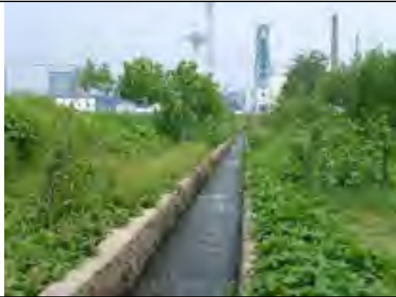
煤矿工业场地排水口（总排口）
