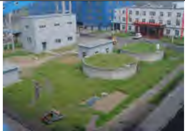
消防水池旁绿化
