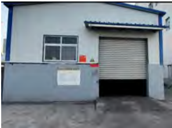
危废暂存间标志
