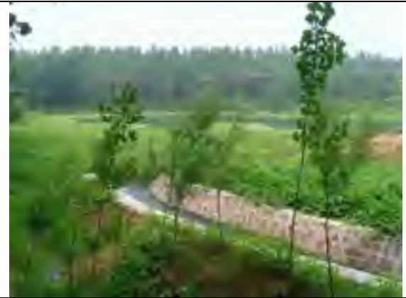
工业场地排水入颍河口（排放口）
