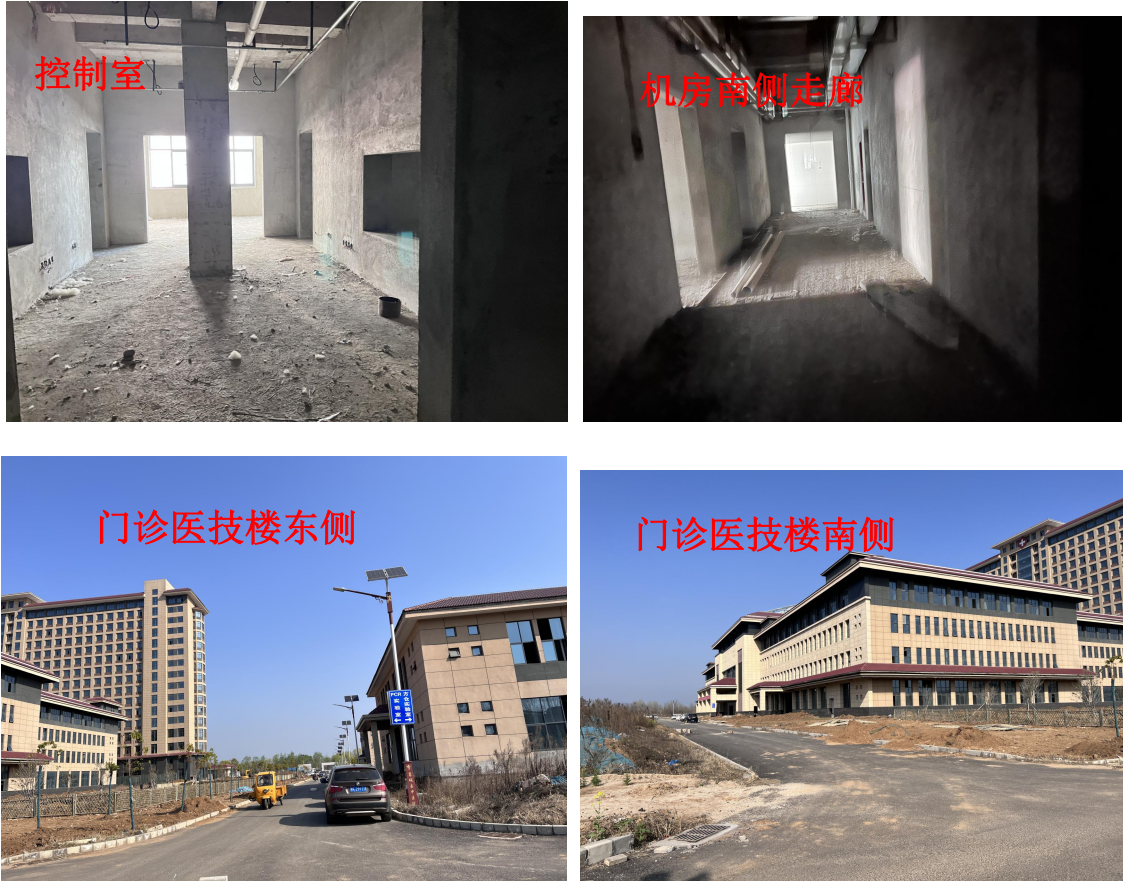
图 1-5 现场勘查照片
