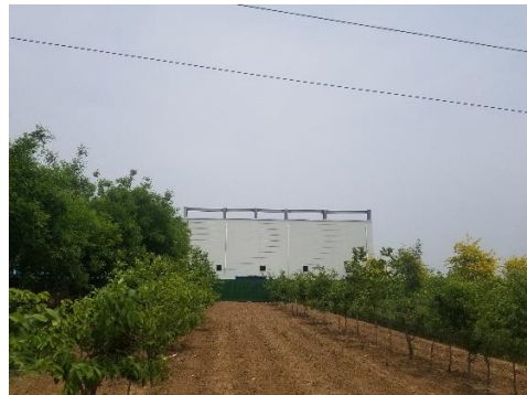
220kV 电气谷变电站出线间隔南侧
