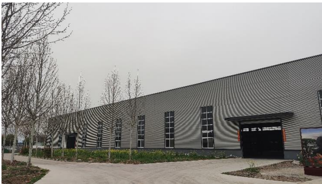
北侧现有车间
