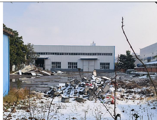
项目现状图（拟建 5#车间）
