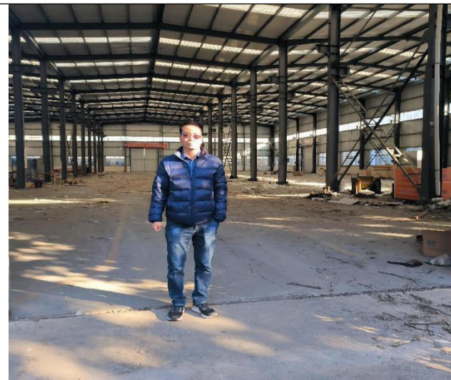
项目现状图（工程师看现场）
