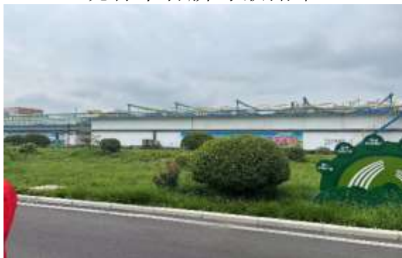
现有污水处理站
