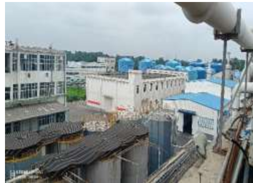
现有草甘膦车间配套罐区
