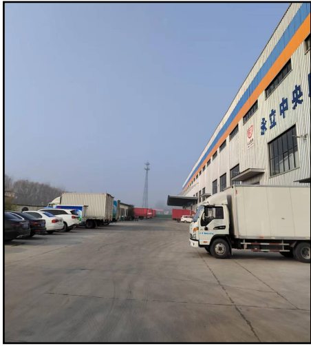
厂房南侧道路
