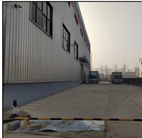
厂房西侧硬化地面
