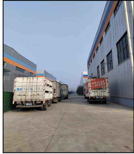
厂房西侧道路
