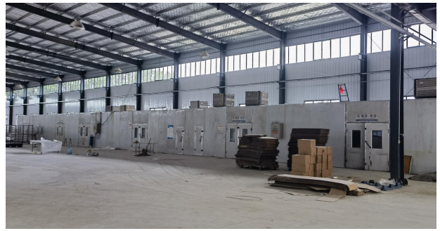
生产车间内部
