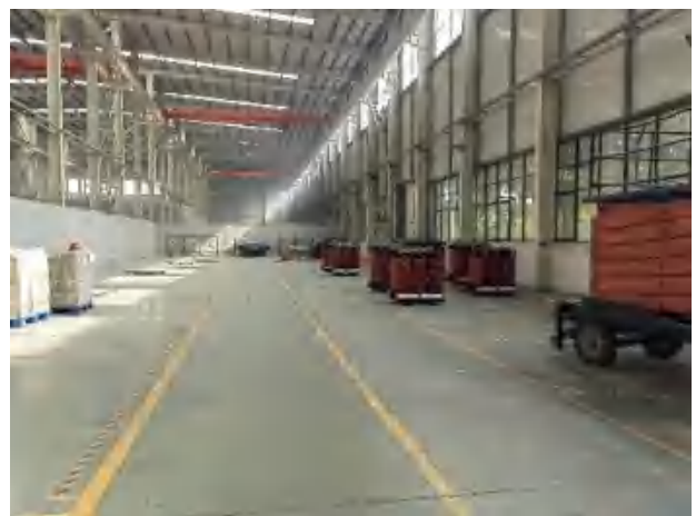
项目现状--空厂房
