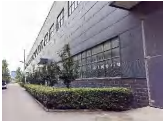
项目北侧--1#厂房（北厂房）
