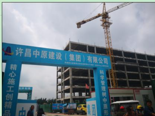
仓储配送中心大门及现状
