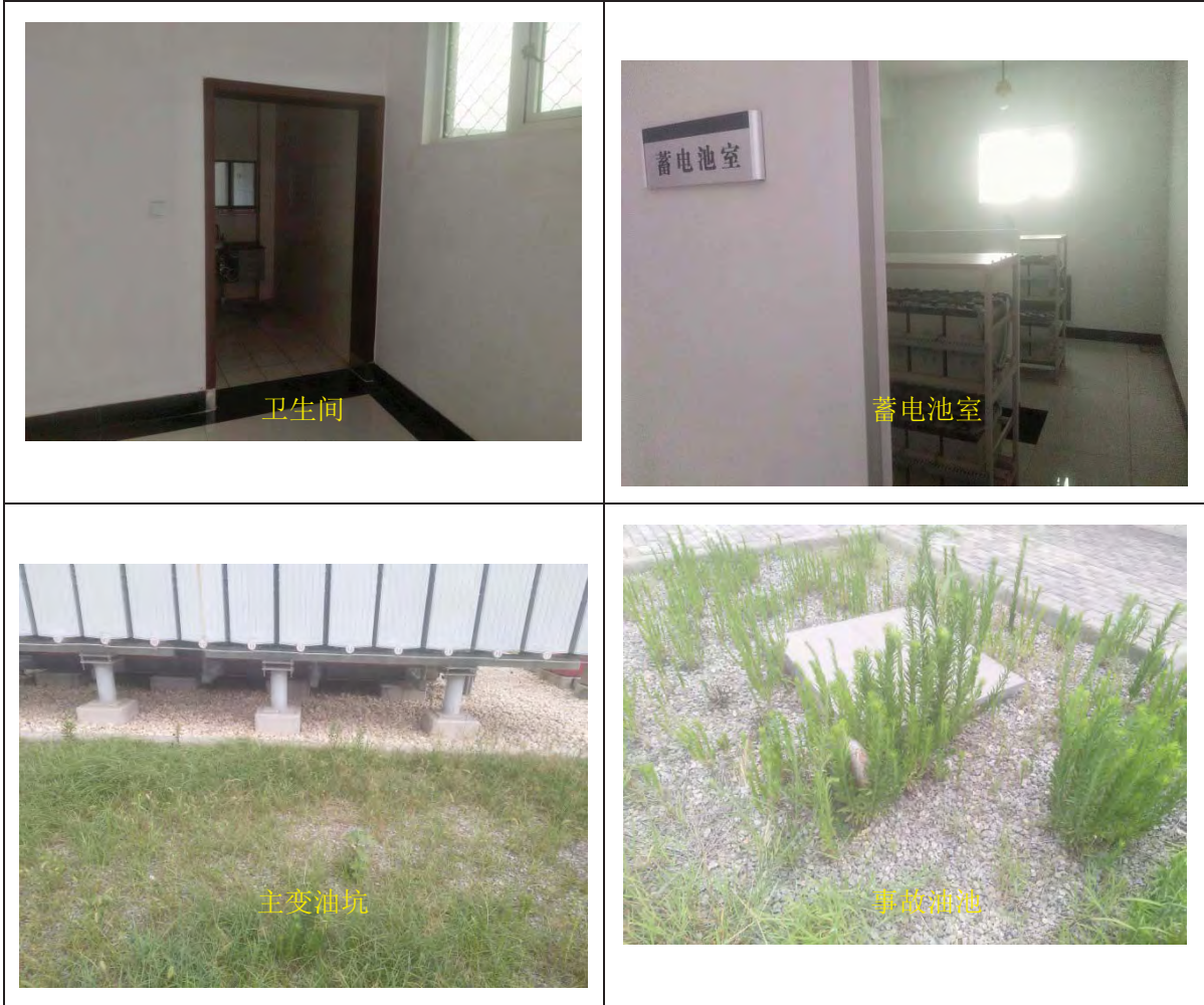
图 1-5 屯田 220kV 变电站站内环境保护设施现状照片
