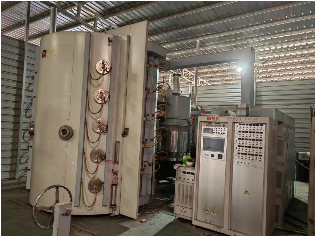
现场建设照片
