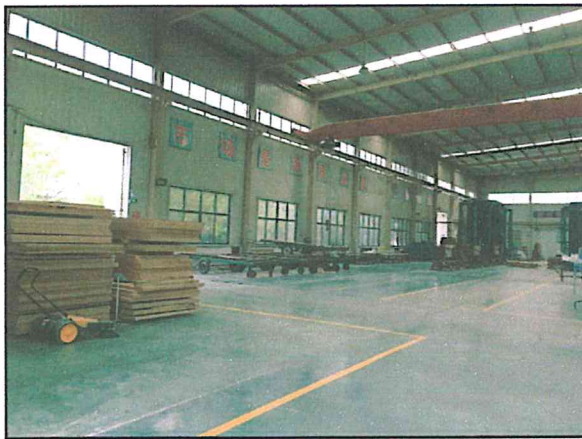
项目厂房现状
