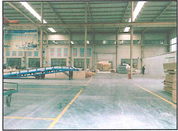
项目厂房现状
