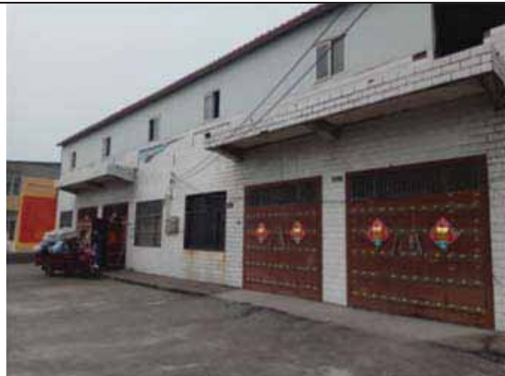
110kV 付庄变~泉店变输电线路 西侧 16m 赵松贵家 2F 民房
