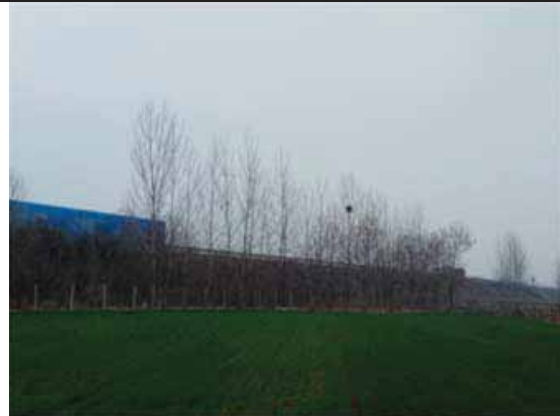
110kV 付庄变~泉店变输电线路 跨越永登高速位置
