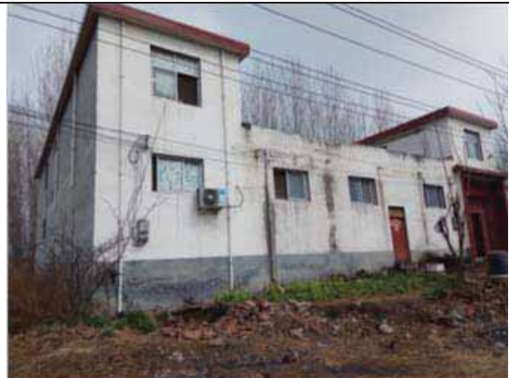
110kV 泉店变拟建址东南侧 高翠莲家 2F 民房
