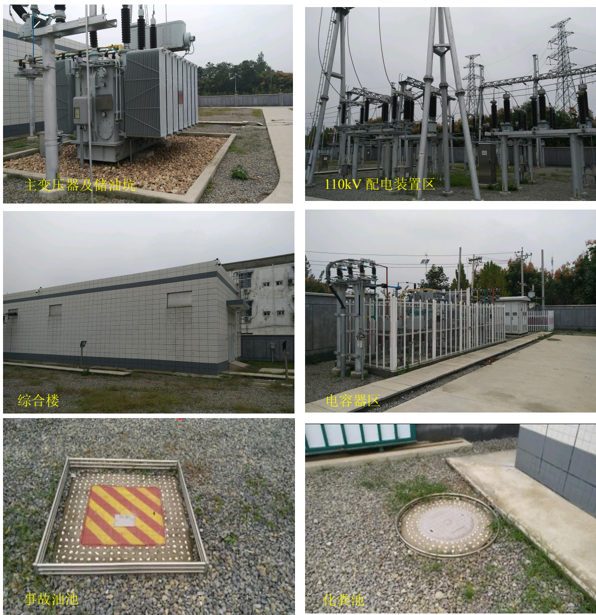
图 1-2 柏梁 110kV 变电站站内已建工程现状照片
