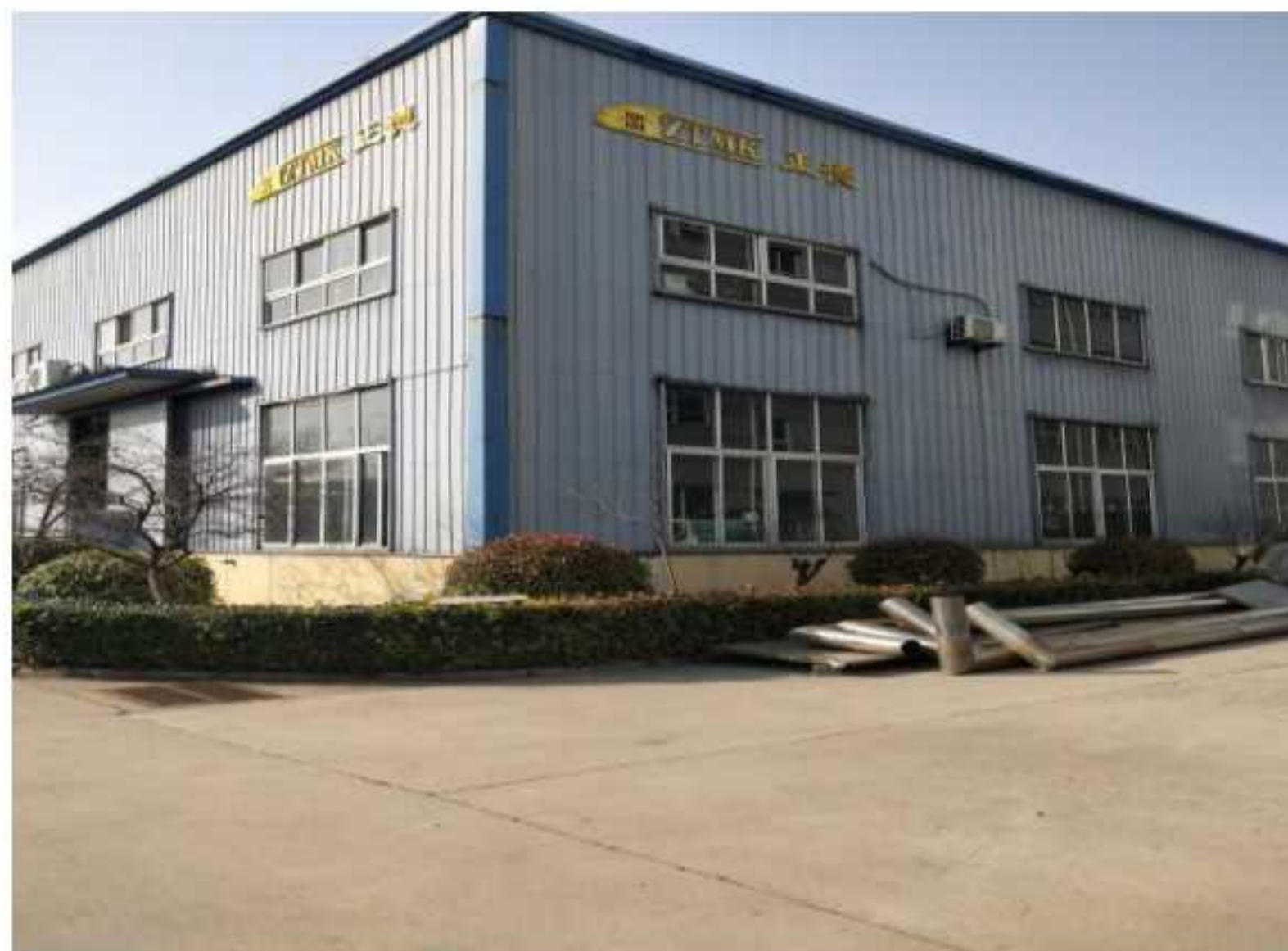
许昌正德铸造有限公司厂房
