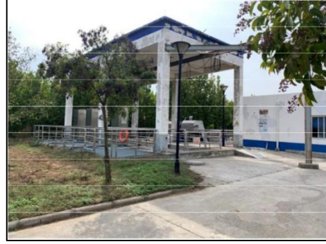
粗格栅及进水泵房
