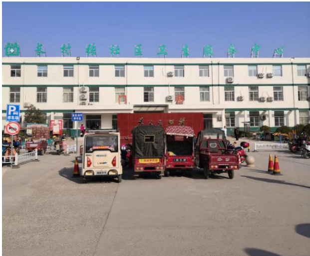
项目西侧卫生院
