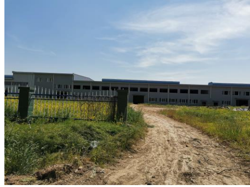
场址东侧振德扩建工程
