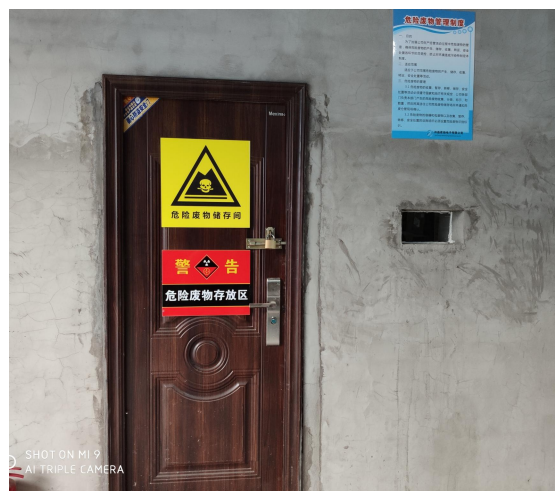
项目现状--现有危废暂存间
